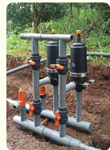
Lắp xả ngược 2 lọc 60
