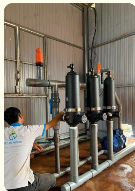
Lắp xả ngược 3 lọc 90
