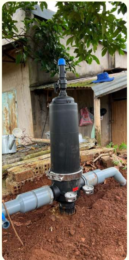
Lắp thủ công 1 lọc 90
