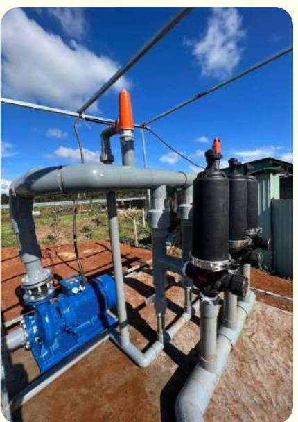
Lắp xả ngược 3 lọc 90
