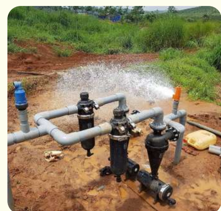
Lắp thủ công 2 lọc 60
