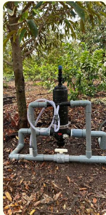
Lắp thủ công 1 lọc 90
